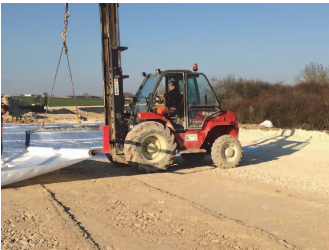
Figure 13. Mise en œuvre du géosynthétique de renforcement
