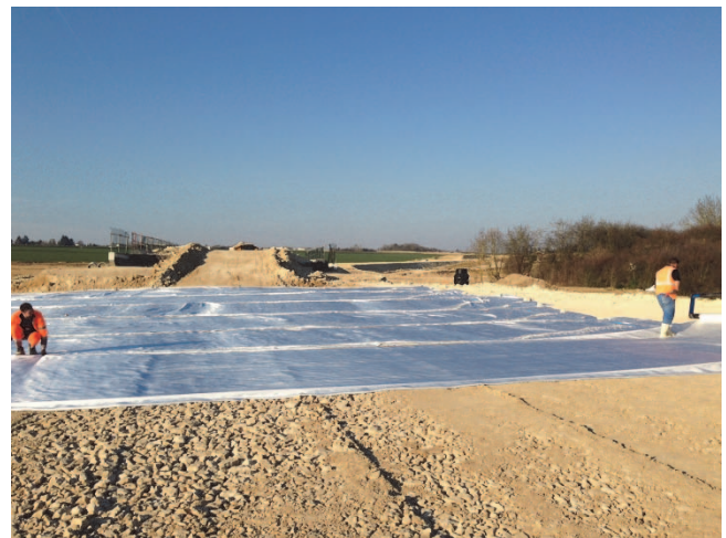
Figure 13. Mise en œuvre du géosynthétique de renforcement
